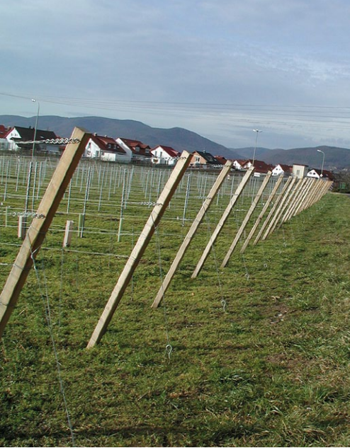
Eine gut durchdachte Endpfahlgestaltung spart Arbeitszeit.
