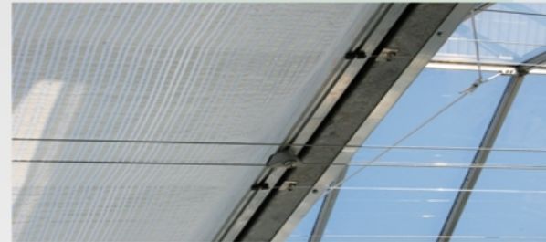
Energieschirm mit Aluminiumführungsprofil im geschlossenen Zustand
